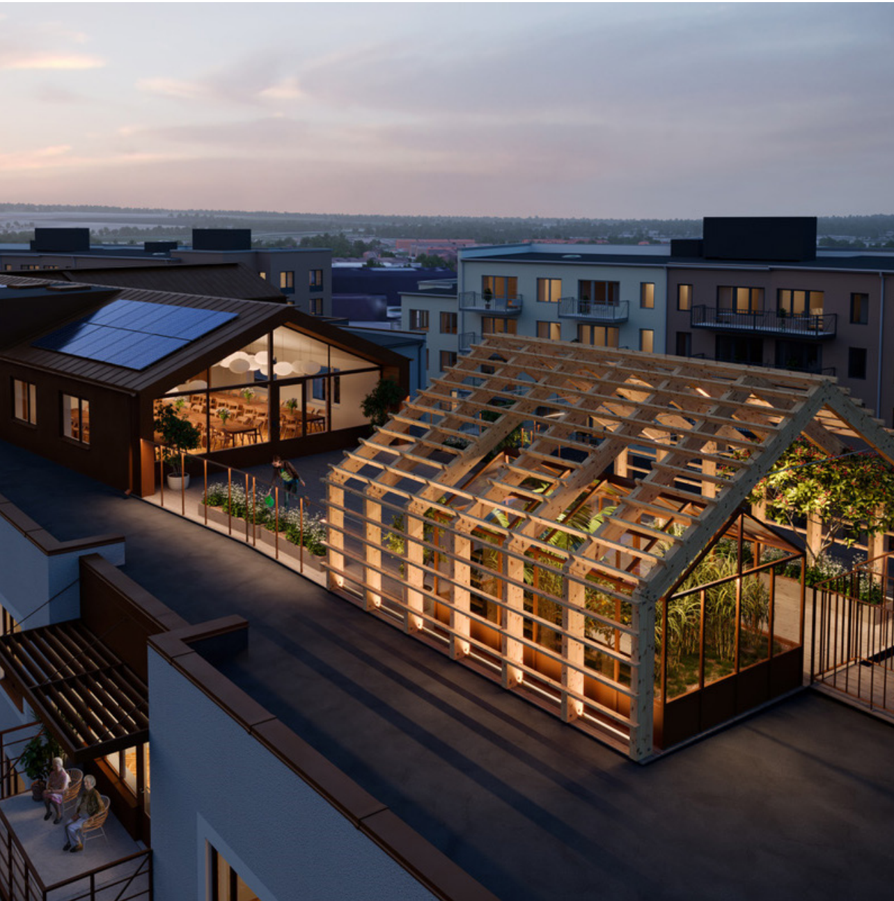
Renderad bild av växthuset vi bygger på taket till äldreboendet i Vallentuna.
